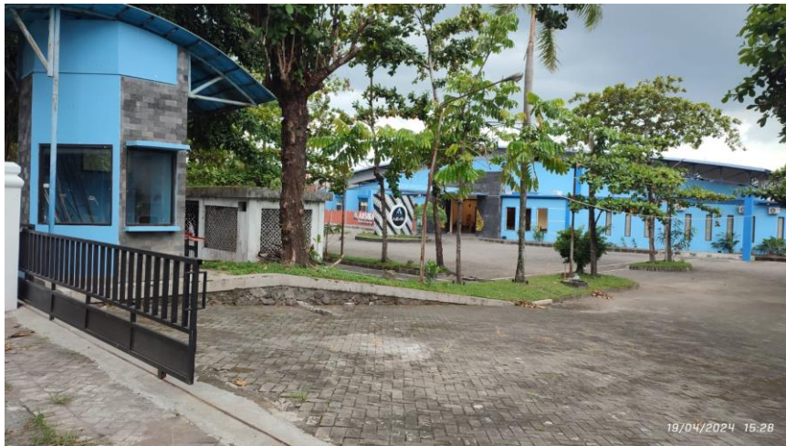
Gambar 3.8 Lokasi PIH depan Embung Giwangan
